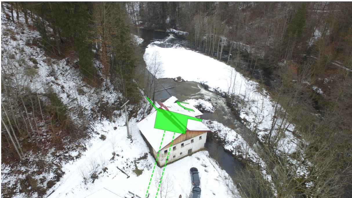
Standort neues Einlaufbauwerk und Unterflur-Rohrleitung (Quelle Dipl. Ing. Fh Haisch)
